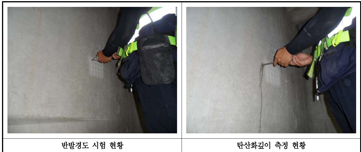
【사진 40.4.1】 콘크리트 내구성조사 현황
