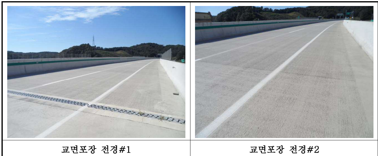
【사진 40.3.19】 교면포장 전경
