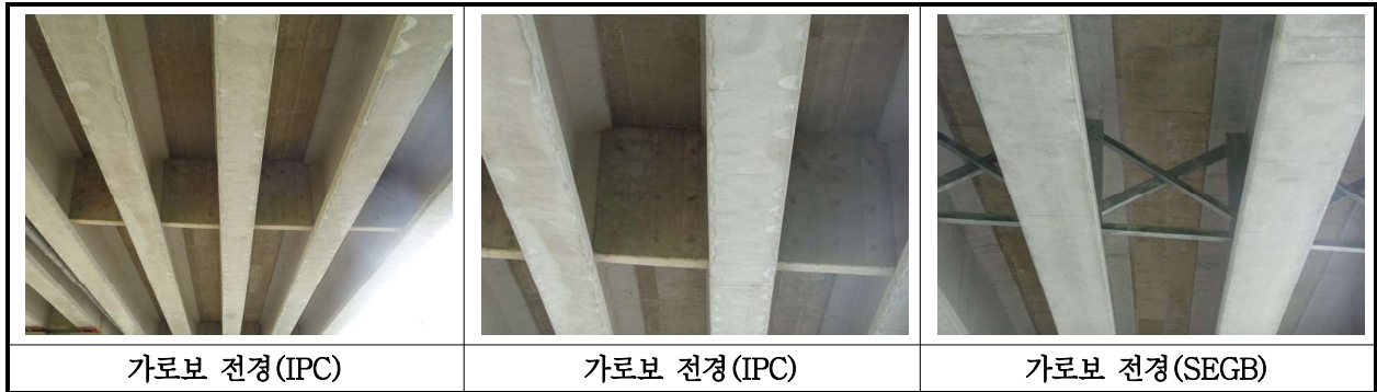
【사진 40.3.6】 가로보 전경
