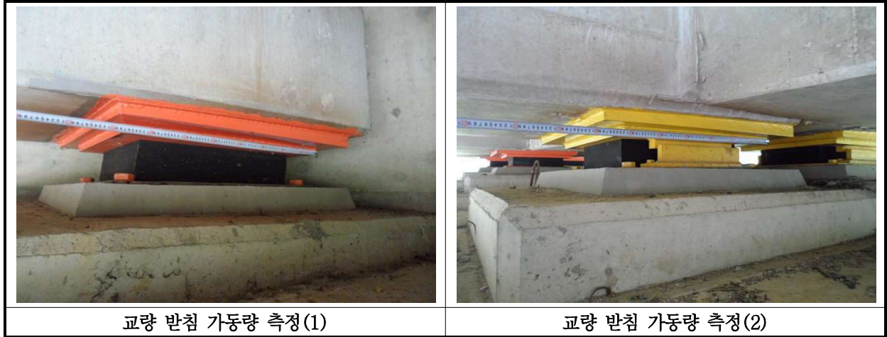
【사진 40.3.15】 교량받침 이동량 측정
