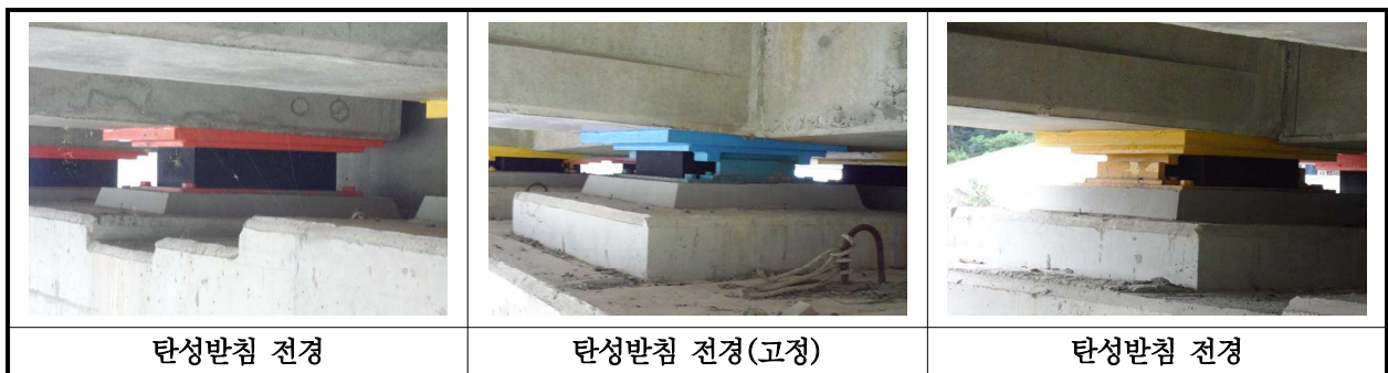
【사진 40.3.12】 교량받침 전경
