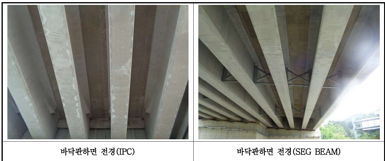
【사진 40.3.2】 바닥판하면 전경
