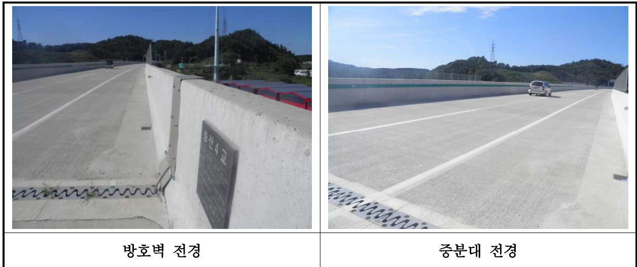
【사진 40.3.23】 방호벽 및 중앙분리대 전경
