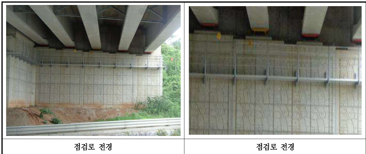
【사진 40.3.25】 교량 점검시설 전경
