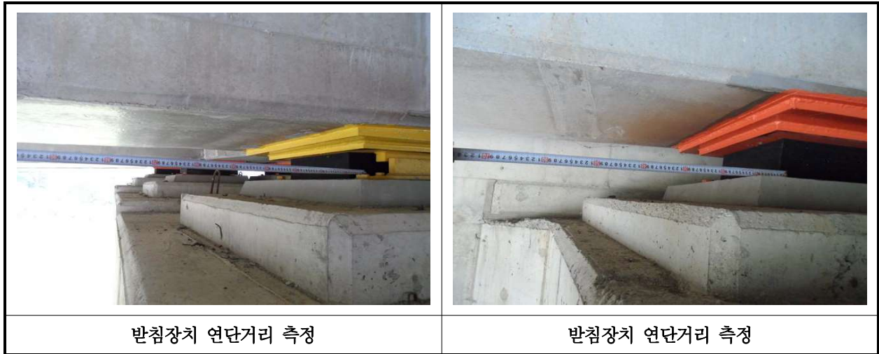
【사진 40.3.14】 교량받침장치 연단거리측정
