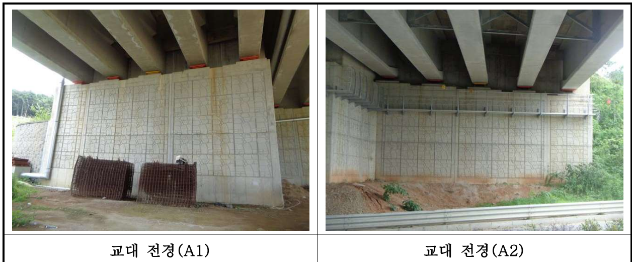
【사진 40.3.8】 교대 전경
